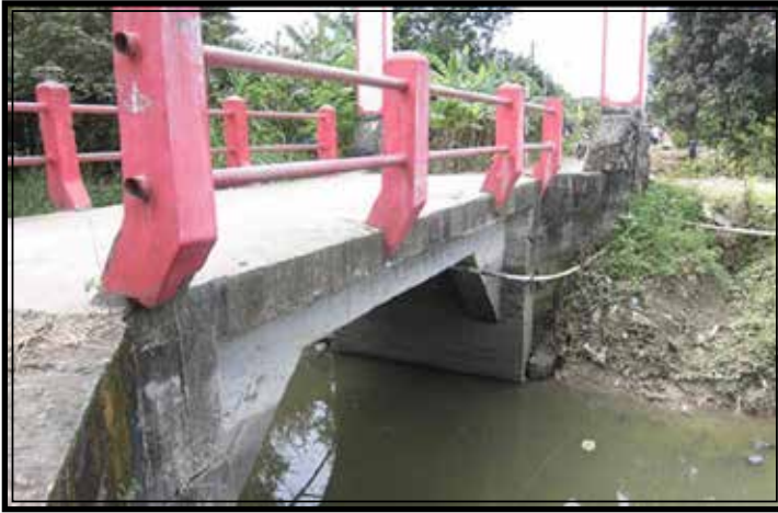
Gambar 2.13 Jembatan beton bertulang
