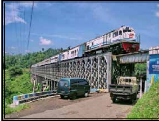
Gambar 2.25 Jembatan Lantai Ganda
