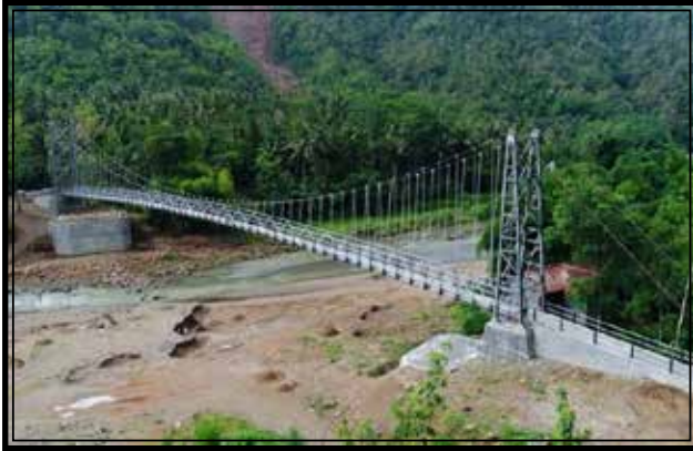
Gambar 2.23 Jembatan Lantai Bawah
