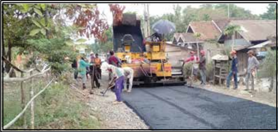
Gambar. 4.1 Proses Pembuatan Jalan
