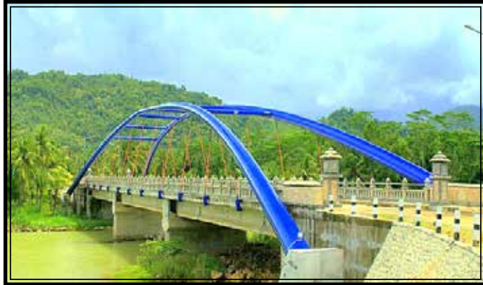
Gambar 2.15 Jembatan Komposit Sumber: boby, 2019 (dokumen pribadi)
