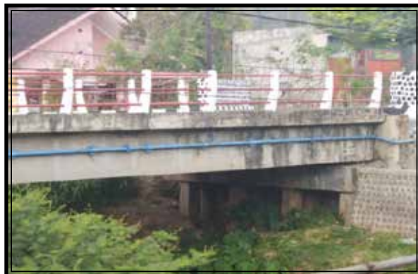
Gambar 2.22 Jembatan lantai atas
