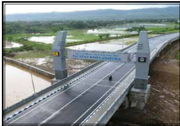
Gambar 2.6 Jembatan Jalan Raya
