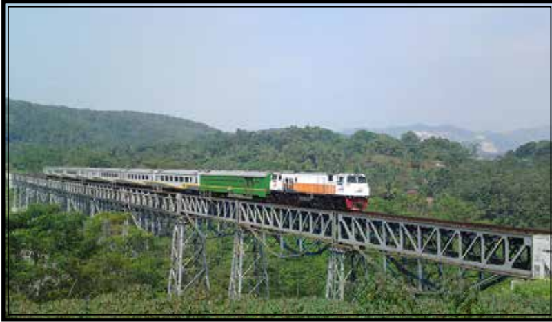
Gambar 2.7 Jembatan jalan rel kereta api
