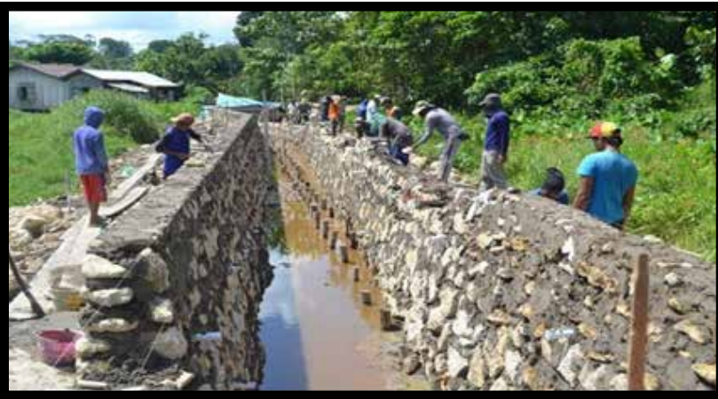
Gambar 6.1 Pekerjaan Pembuatan Drainase
